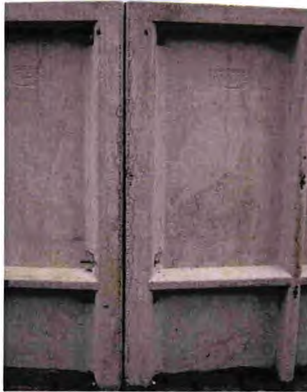
Pre Pour Inspection – Panel jointing 5/12/2012
