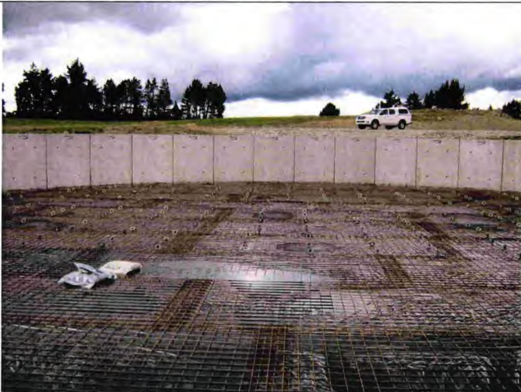
Pre Pour Inspection – Slab floor 5/12/2012
