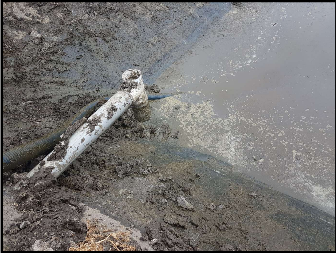
Figure 6 : Effluent outlet pipe
